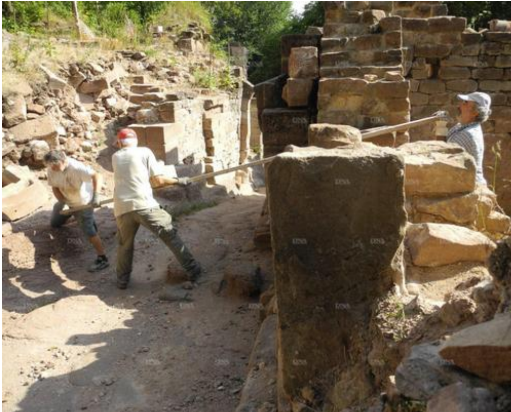
Un gros chantier pour dégager l'entrée originelle du château. PHOTOS DNA - S.G.
