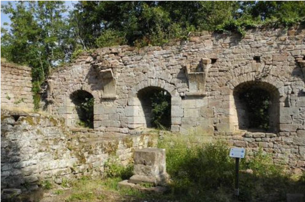
La restauration du mur extérieur du palas va être confiée à une entreprise spécialisée.
