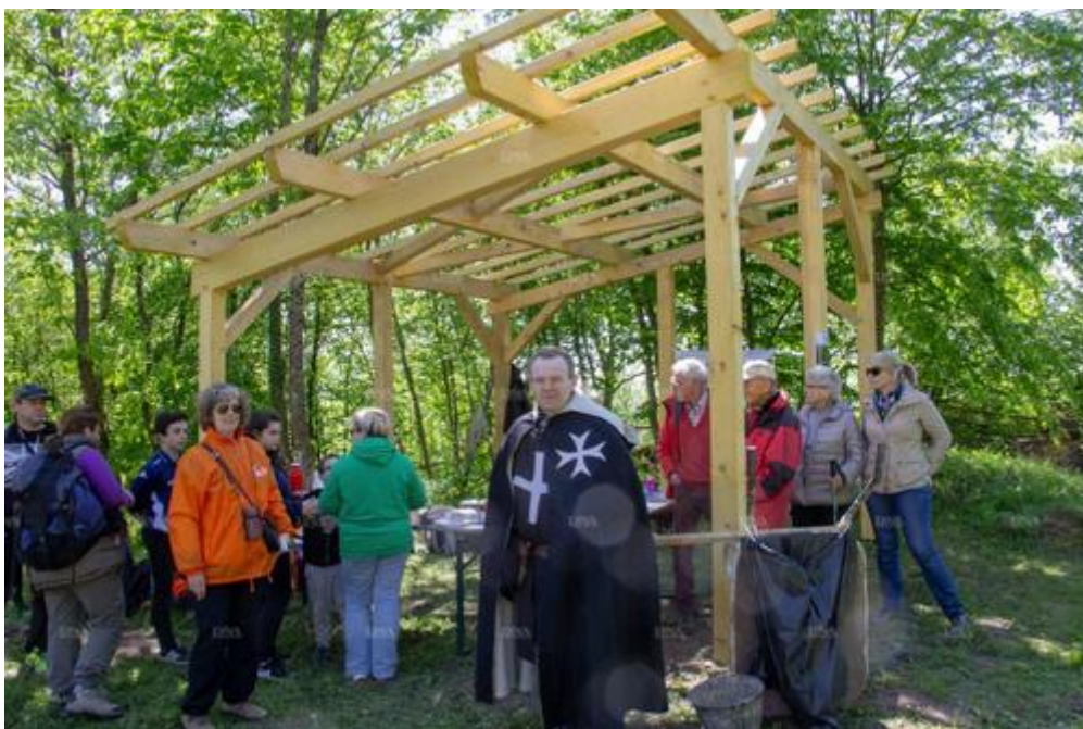
Un preux chevalier devant le nouvel abri, dont la charpente vient d'être terminée. PHOTO DNA
